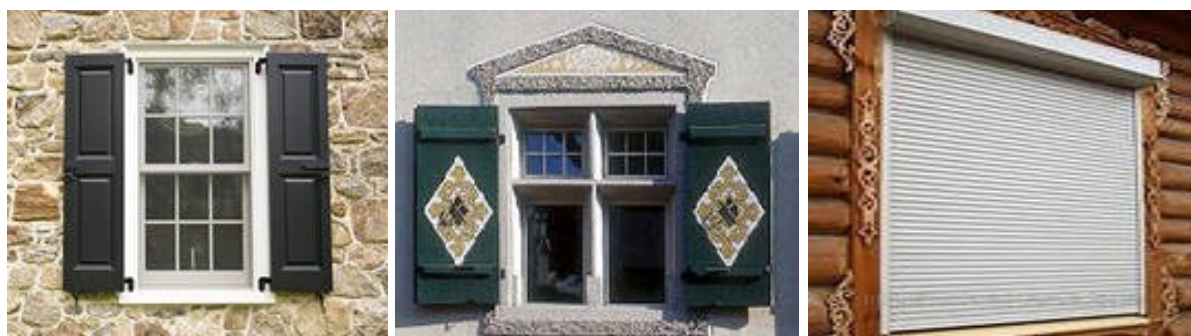
Рис 5.5.14. Установленные металлические и декоративные ставни, рольставни на оконных проемах в зданиях
