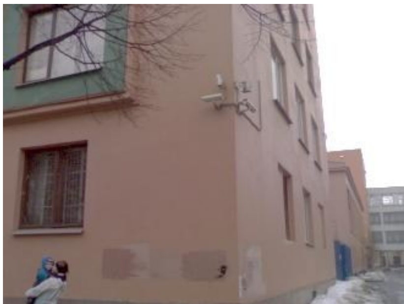
Рис. 5.4.76. ТК для контроля зоны вдоль здания
