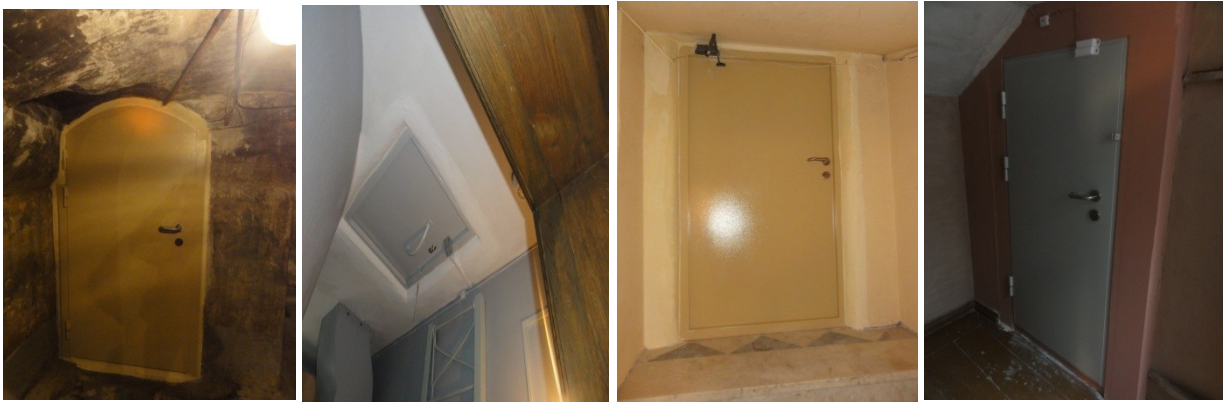
Рис. 5.5.11. Заменены старые и установлены новые двери на объектах ГМЗ «Петергоф»
