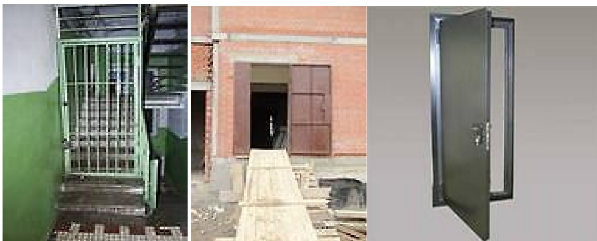
Рис 5.5.10. Варианты дверных конструкций внутренняя решетчатая дверь на чердак, дверь эвакуационного выхода и металлическая противопожарная дверь фондохранилища
